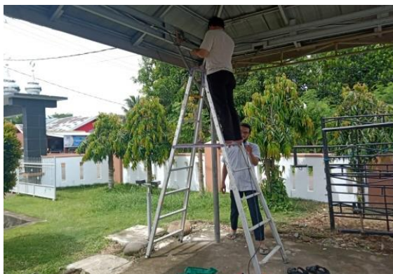
Gambar 6. Kegiatan Pemasangan Instalasi Kran Less Contact
