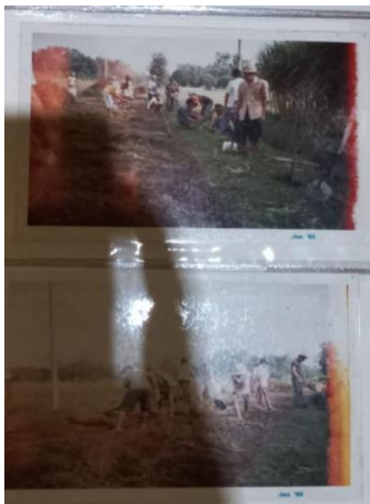
Gambar 3. Beberapa Proyek Jalan Baru di Desa Bendorejo
