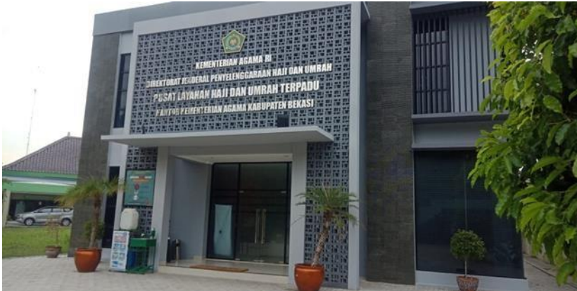
Gambar 1 Gedung PLHUT Kabupaten Bekasi
